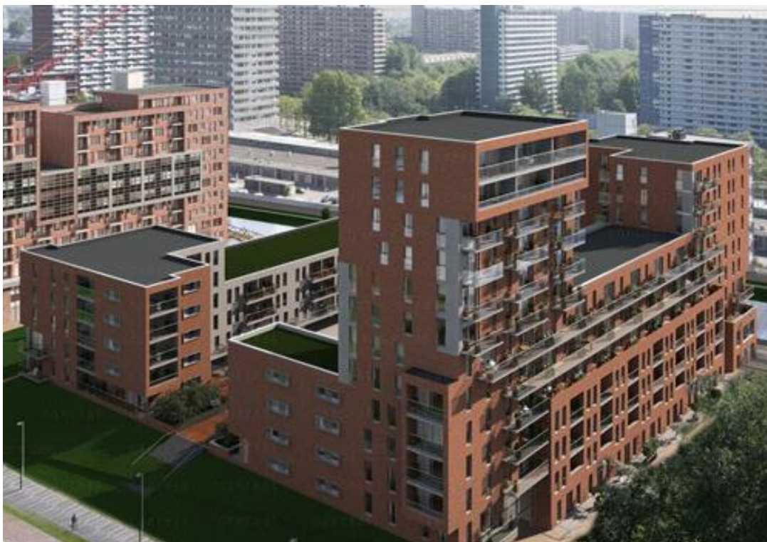
Beeld van een deel Poptahof te Delft na de renovaties (Nederland) (Bron: https://mekan.nl/portfolio/poptahof-delft )
