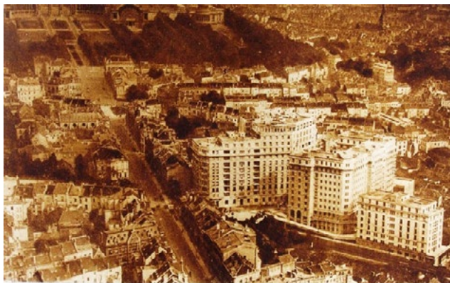
Vue aérienne du Résidence-Palace, à Bruxelles.
