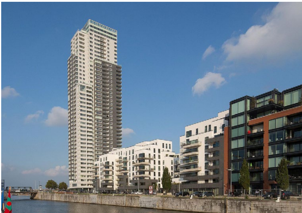
Zicht up de UP-site met de woontoren. (Bron: http://www.atenor.be/nl/projects/77-up-site )
