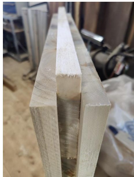
Figuur 11 CLT tand-en-groef paneel (Eigen foto, 2025)
