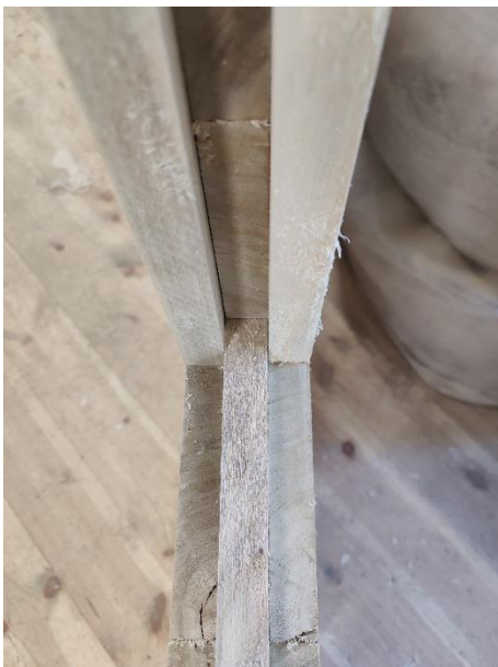
Figuur 12 CLT tand-en-groef panelen (Eigen foto, 2025)
