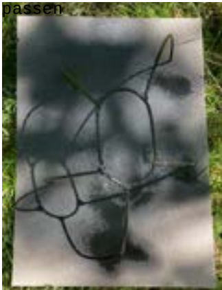
stalen frame zwart spuiten & punten frame schuren zodat ze perfect in het frame passen
