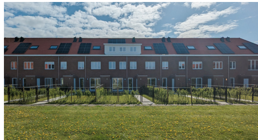
Figuur 6: woningen met zonnepanelen - © WISH-team
