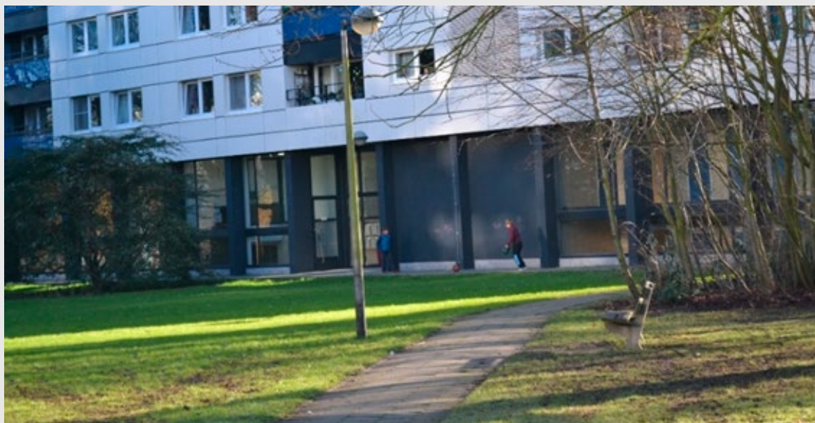
Fig. 36: Ruimte achter de blok Dennenhof. Spelende kinderen maken gebruik van de blinde muren van het gebouw om een balspel te spelen
