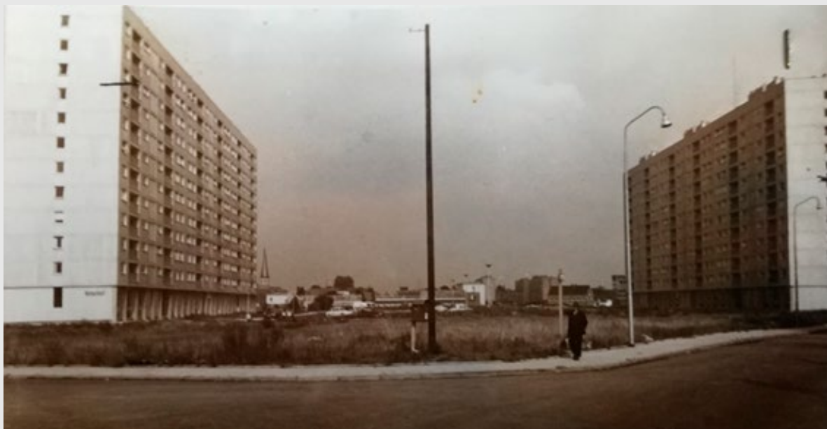
Fig. 43: Foto met het zicht op de zone tussen Rozenhof en Dennenhof. Op de achtergrond zie je de kerk van Ekkergem. Merk op dat het zicht tussen de blokken zeer open is (Bron: Archief de Zwarte Doos Gent)
