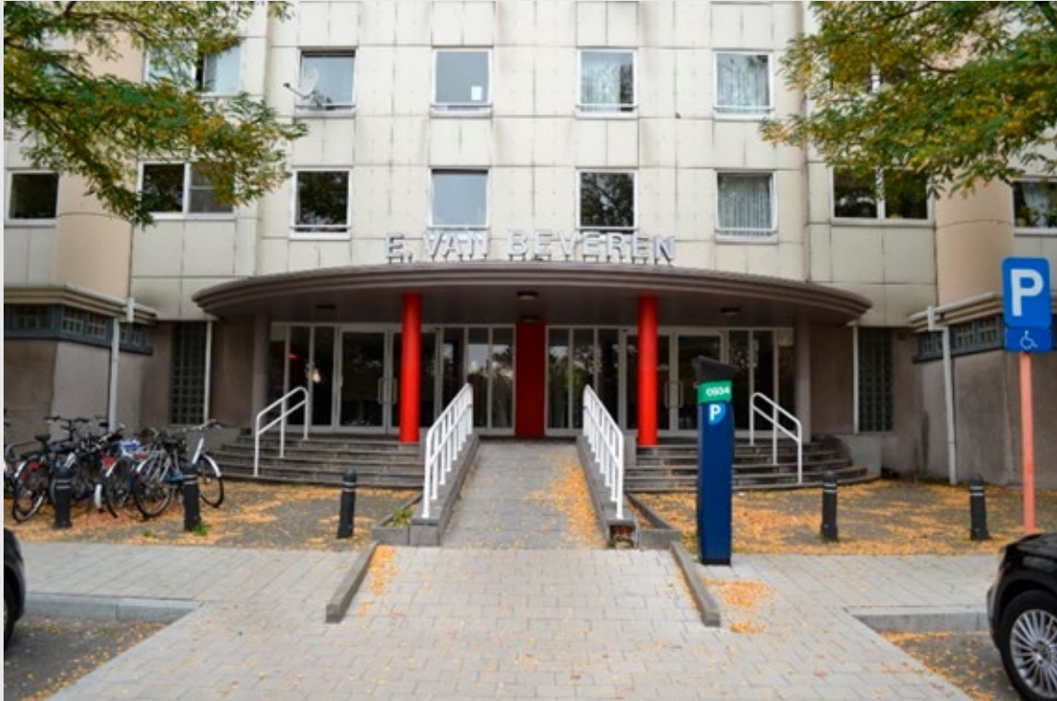
Fig. 25: Door een gebrek aan formele ontmoetingsruimtes in de gebouwen en omwille van logische redenen van passage is de ingang van de gebouwen een zeer belangrijke ontmoetingsplek voor bewoners uit hetzelfde gebouw. Bij de gebouwen Anseele en Van Beveren wordt dit gefaciliteerd door het afdakje waardoor de plek meer bruikbaar wordt
